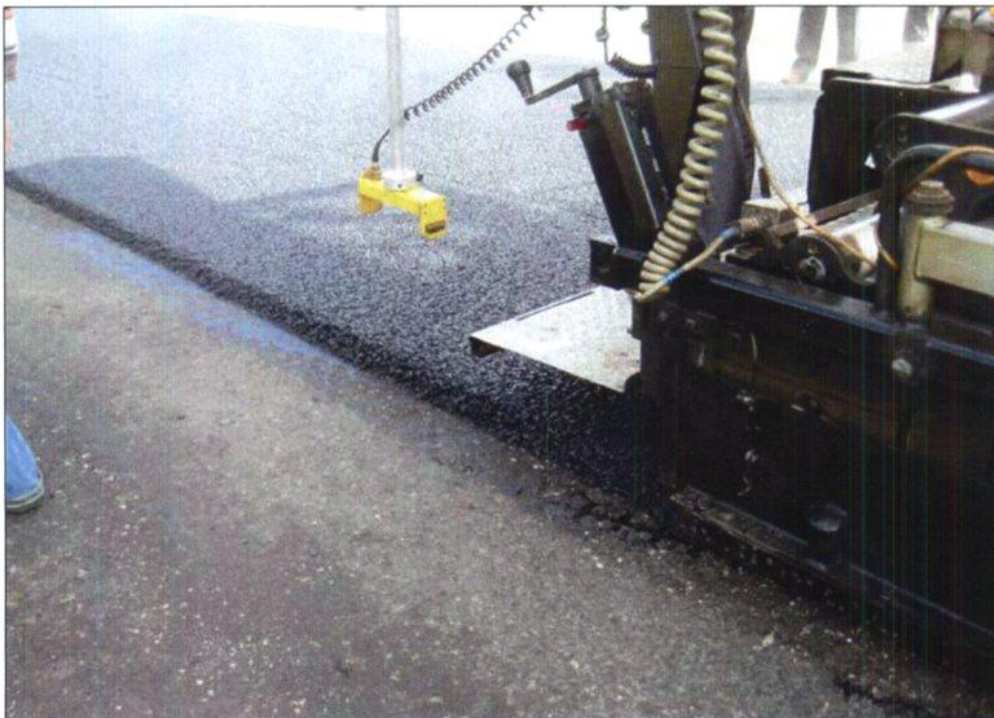
Слой смеси ЩМА 50 мм был произведен на заводе Astec со смесительным барабаном Double Barrel, принадлежащем компании «Камдорстрой».
