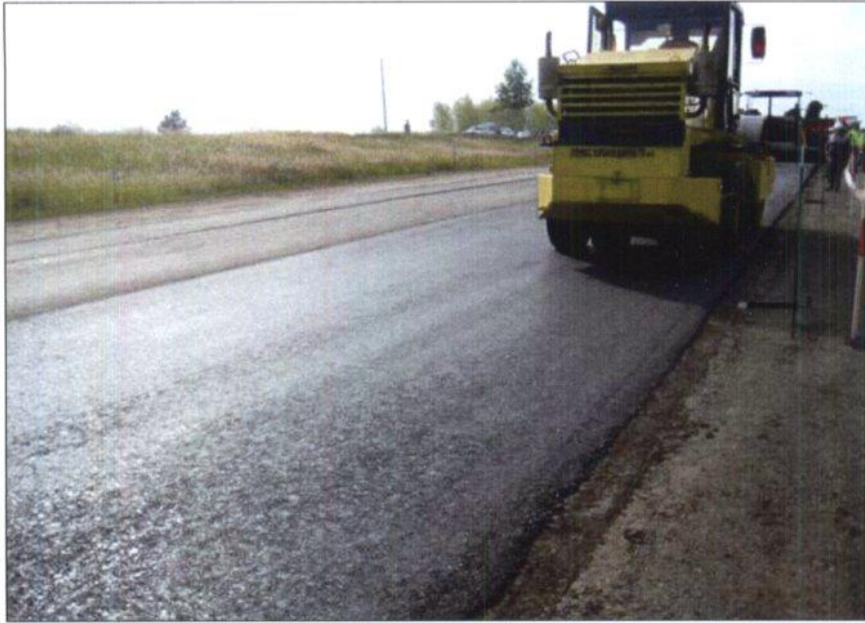
Комбинированный каток уплотняет переработанную смесь основания
