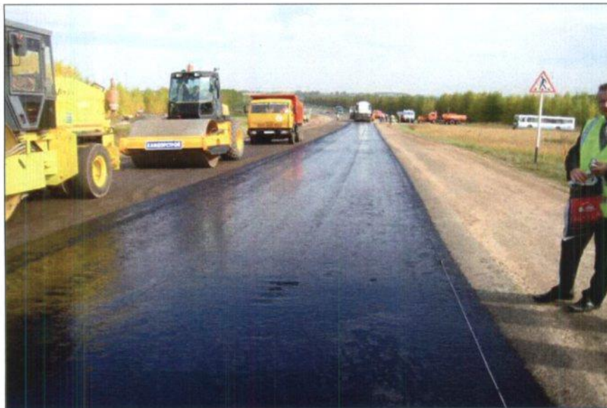
Слой битумной эмульсии на затвердевшем основании. Катки на левой стороне уплотняют новое переработанное основание. Вдалеке - перегружатель асфальтовой смеси Shuttle Buggy.
